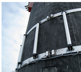
Arreglos Cuando los tubos de luz se instalan formando arreglos en la superficie de una ayuda a la navegación, la luz crea una buena impresión visual del área iluminada. Esto permite que los navegantes detecten fácilmente la estructura.
